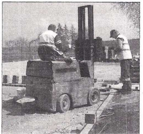
W Świerczyńcu zakończono w tym roku budowę parkingu przy szkole
