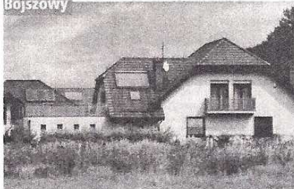
↑ W gminie Bojszowy pod Tychami widać efekt dopłat – kolektory, a nie widać czarnego dymu
