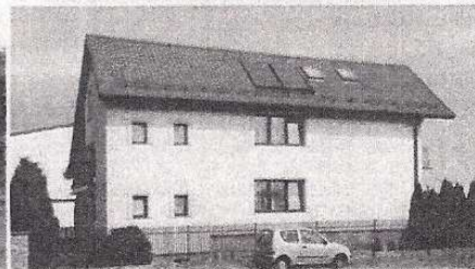
↑ Wielu mieszkańców zdecydowało się na dwie inwestycje – kocioł i kolektor. Ten kolektor ma powierzchnię 5,2 m 2 . Zastąpił elektryczny przepływowy podgrzewacz wody o mocy 24 kWh. Ogrzewa 500 l wody użytkowej. Latem właściciele oszczędzają 150 zł miesięcznie
