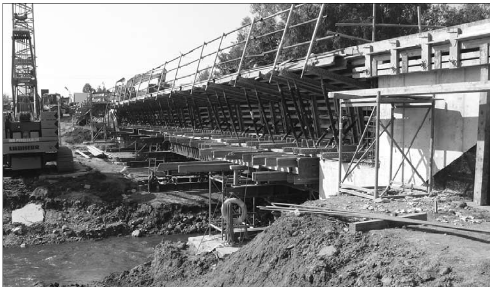
Budowa mostu na Pszczynce
