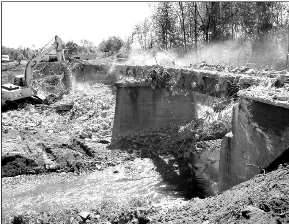
W maju rozpoczęto odbudowę mostu na Pszczyńce w Jedlinie.
