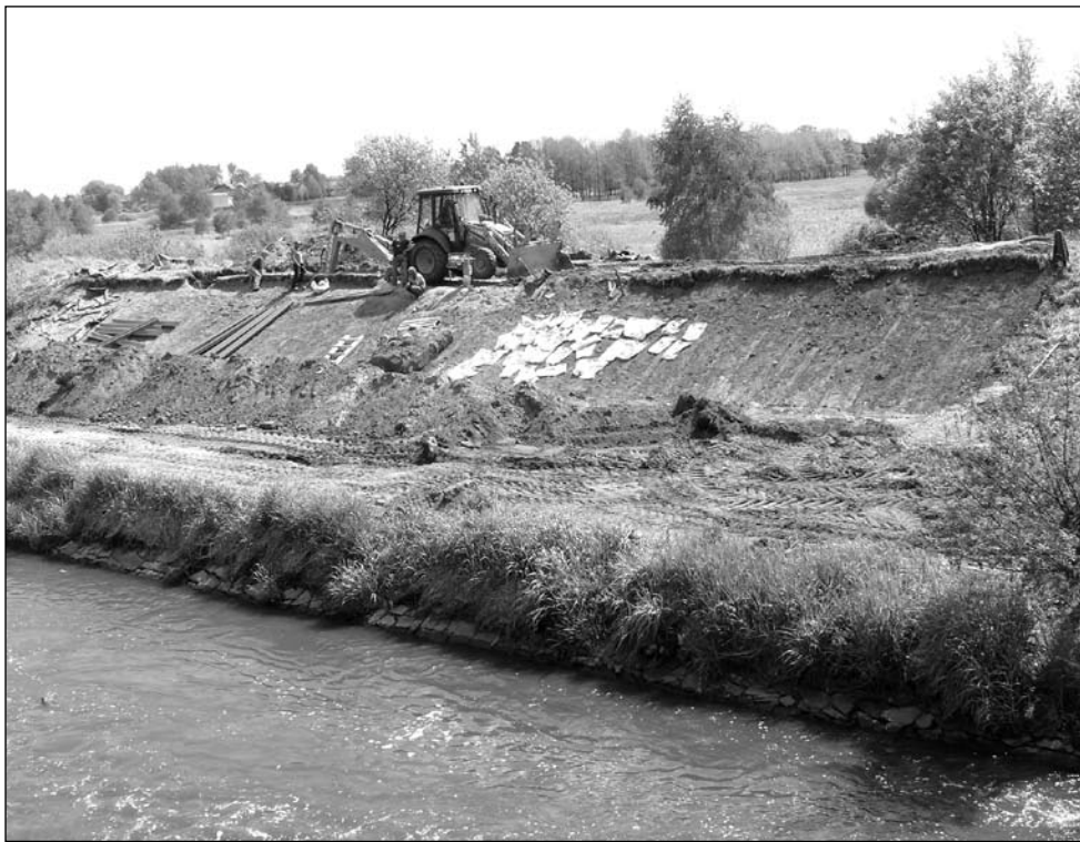
W maju zakończyły się prace przy naprawie rozmytego wału Gostyni (w pobliżu kładki do ERG-u)
