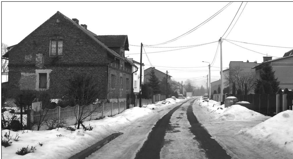
Dworzysko jest jednym miejsc w gminie najbardziej dotkniętych szkodami górniczymi.
