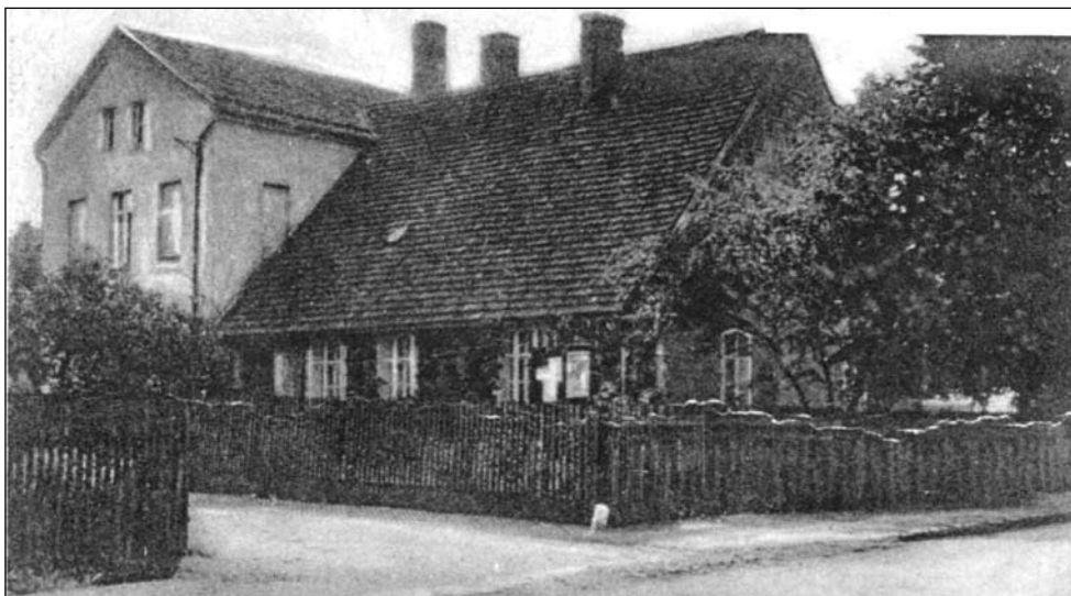
Jeden z dwóch budynków, w których mieściła się przed wojną szkoła, to dzisiejsza siedziba Urzędu Gminy.
