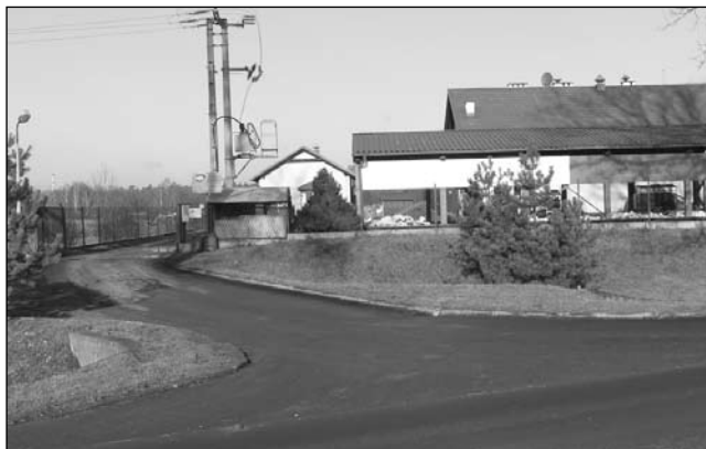
Punkt zbiórki odpadów powstaje na tyłach oczyszczalni ścieków przy ul. Gościnniej w Bojszowach.
