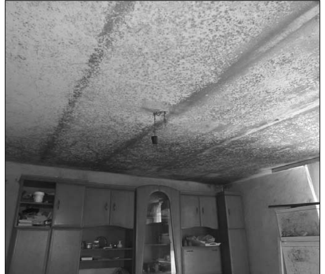
Odpadający ze sklepienia tynk, pękające ściany, nieuszczelny przewód kominowy, zagrzybenia - w takich warunkach trudno mieszkać.
