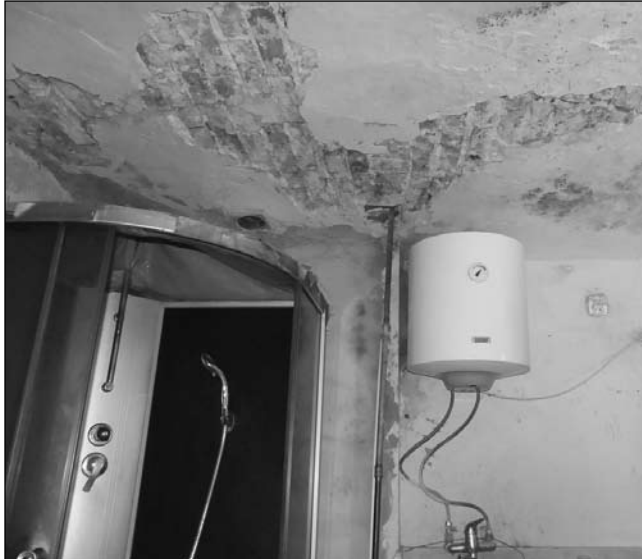
Odpadający ze sklepienia tynk, pękające ściany, nieuszczelny przewód kominowy, zagrzybenia - w takich warunkach trudno mieszkać.
