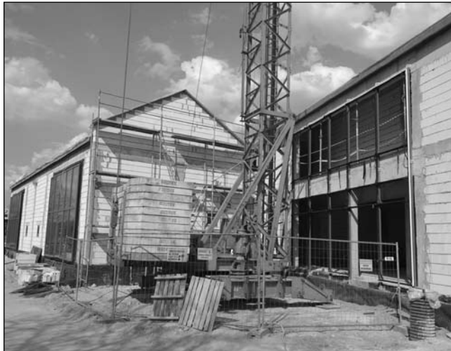
Po lewej na budowie przedszkola, po prawej rozbudowa biblioteki.
