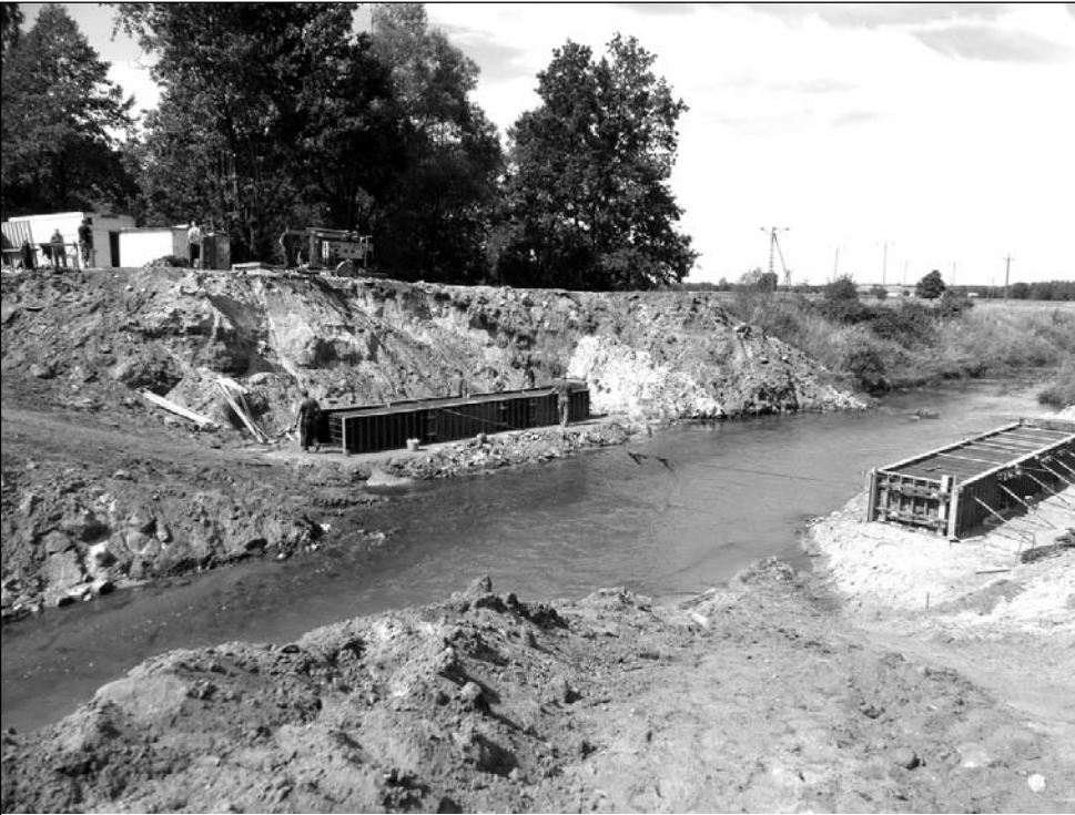
Żelbetonowe odczepy uchronią most na Gostyni przed podmywaniem.
