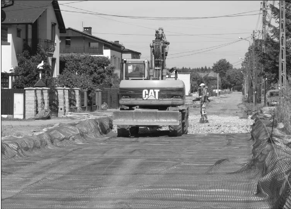
Na ul. Korzenickiej podbudowa z kamienia znajduje się w przepuszczającej wodę geowłókninie.
