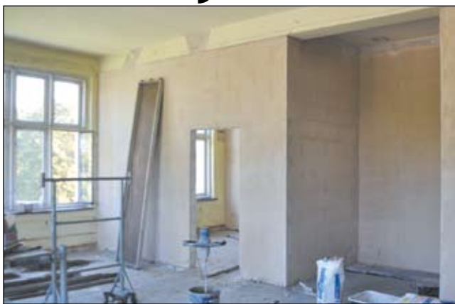
Duża sala na piętrze została podzielona na mniejsze pomieszczenia i stanie się bardziej funkcjonalna.
