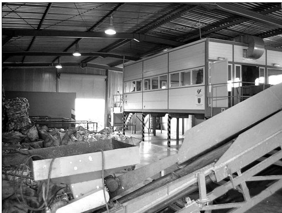
W Tychach za 109 mln zł powstanie jeszcze nowocześniejszy niż istniejąca sortowania zakład utylizacji odpadów. Trafią tu również śmieci z gminy Bojszowy.
