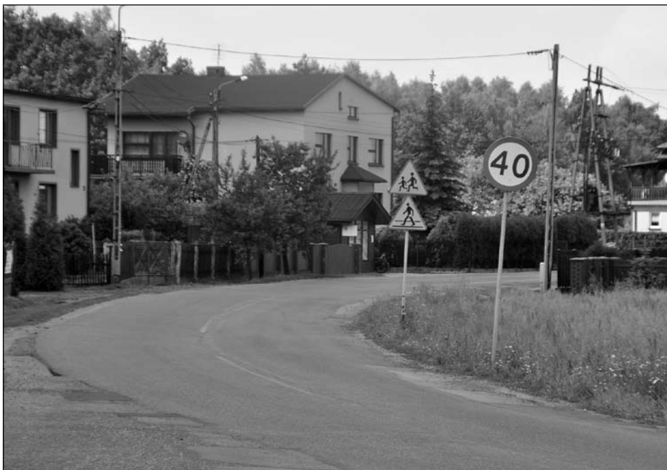
Za prawie 3 mln zł powstanie chodnik, kanalizacja deszczowa i nowy asfalt na ul. Barwnej.
