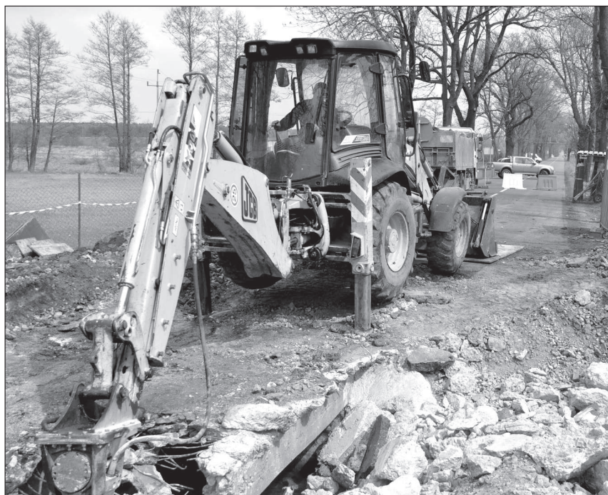
Prace rozpoczęły się od mostu na Młynówce i mają się tu zakończyć w połowie maja.
