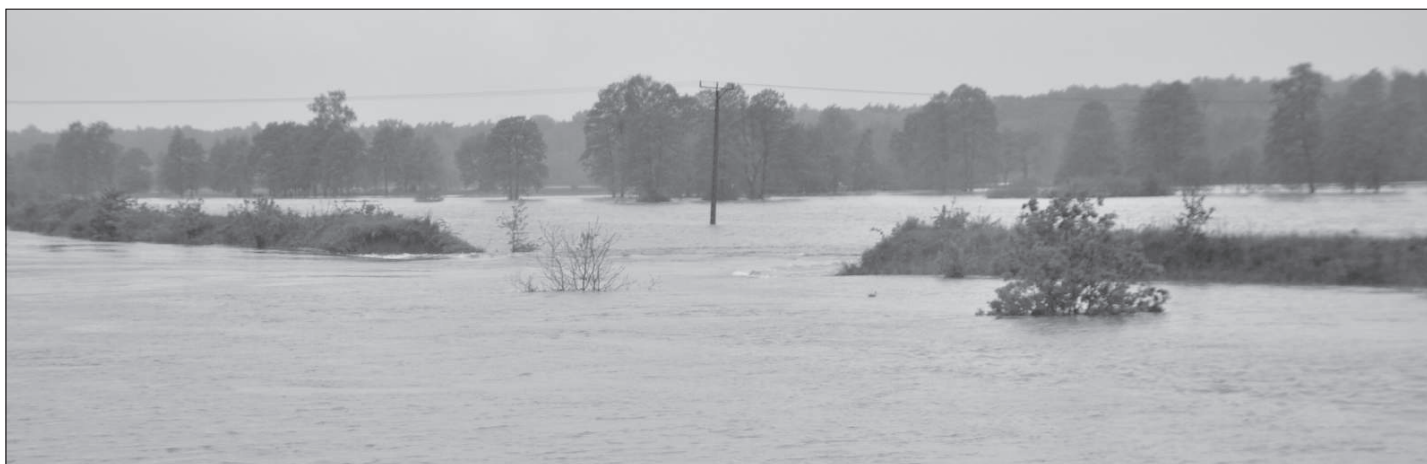
50-metrowa wyrwa w wale Gostyni po stronie Kopani.
