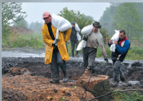
Odbudowa zerwanego wału na Gostyni
