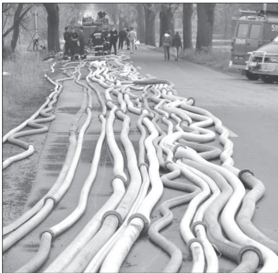
Pompowanie wody zalewającej Dworzysko.
